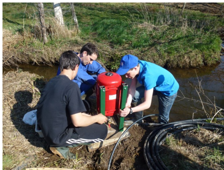
Installation du bélier hydraulique
